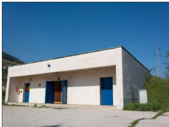
Slika broj 1: Vodovodni objekat „Zmajevac II“
