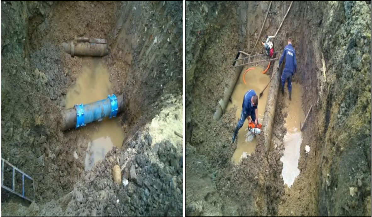
Slika broj 11: Radovi na vodovodnim linijama
