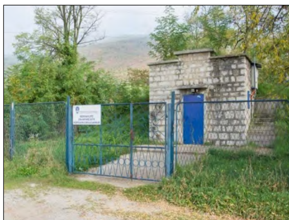
Slika broj 3: Rezervoar „Klopče“
