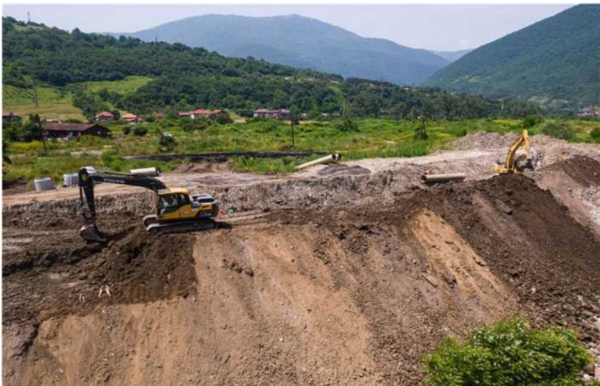
Slika broj 15: Radovi u okviru Projekta "Sakupljanje i tretman otpadnih voda u Zenici"
