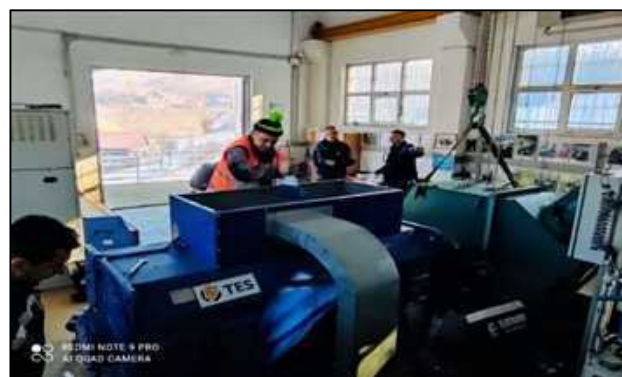
Slika broj 1: Remont mHE Čajdraš
