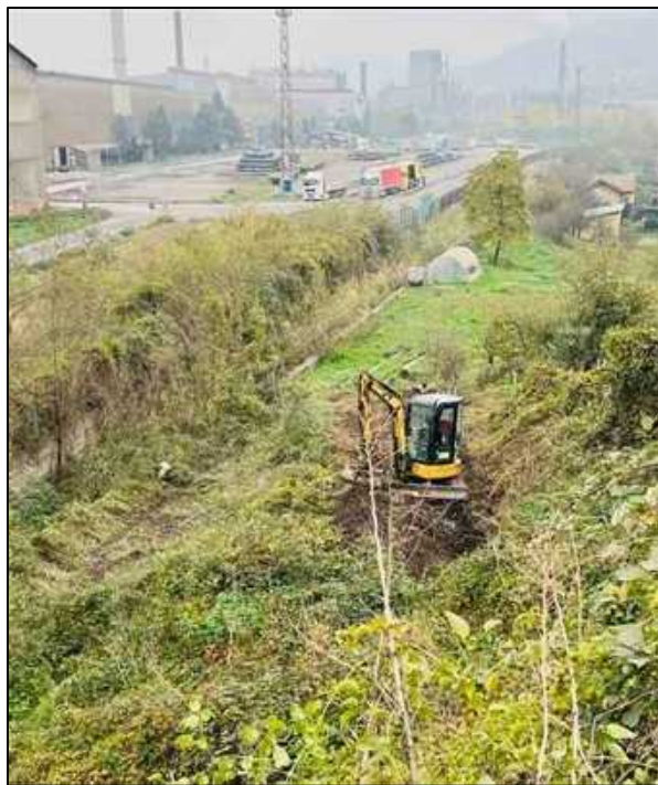
Slike broj 10 i 11: Izgradnja prenosnice na vodovodnoj liniji DN 150 u dužini od 200 metara
