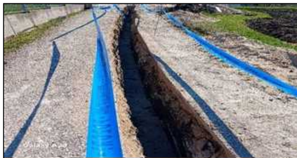
Slika broj 4: Izgradnja vodovodne linije u ulici Klopački put
