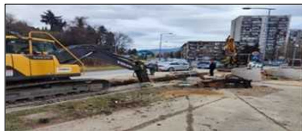
Slika broj 3: Izgradnja prve faze kanal. kolektora Drivuša – Bojin vir
