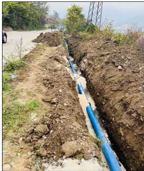
Slike broj 10 i 11: Izgradnja prenosnice na vodovodnoj liniji DN 150 u dužini od 200 metara
